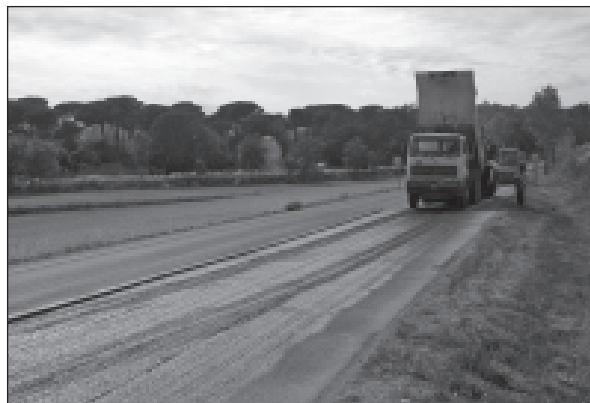
Feines d'asfaltatge del tram pròxim al Llac del Cigne
