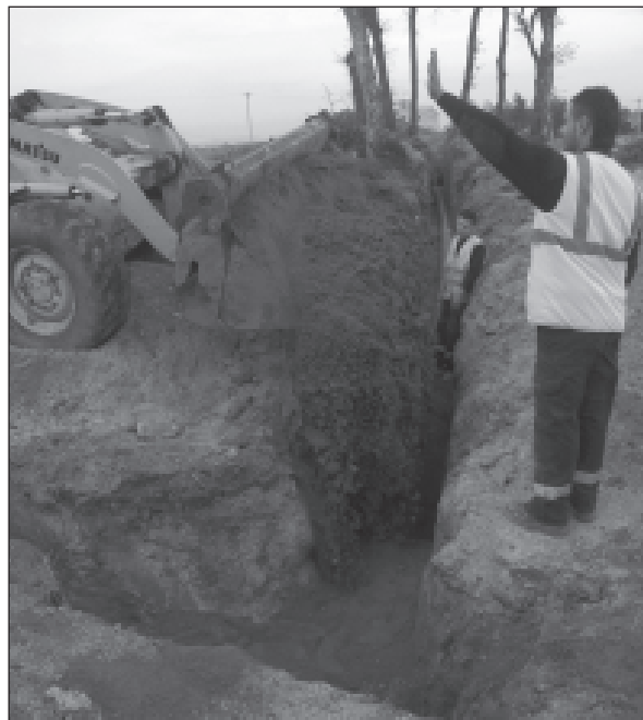
Inici de les obres, el mes de març
