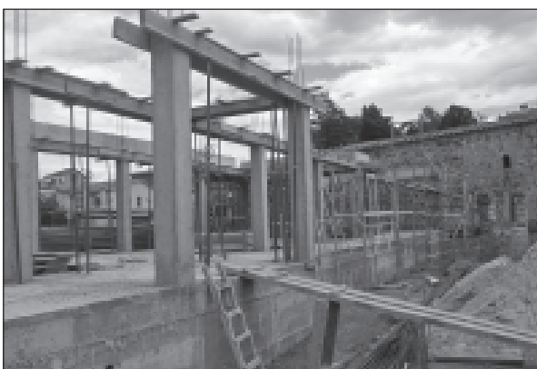
Les obres del nou Ajuntament
