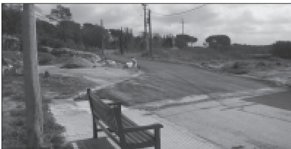
Tram inicial de l'asfaltat nou, al Parc de les Moleres
