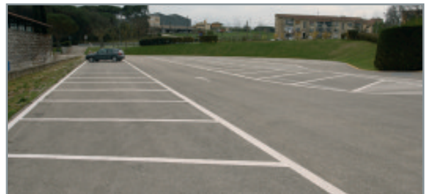
Repintat de l'espai d'aparcaments
