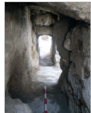
El desguàs termal continua sota del carrer de les Termes Romanes. Foto: Albert Torrent
