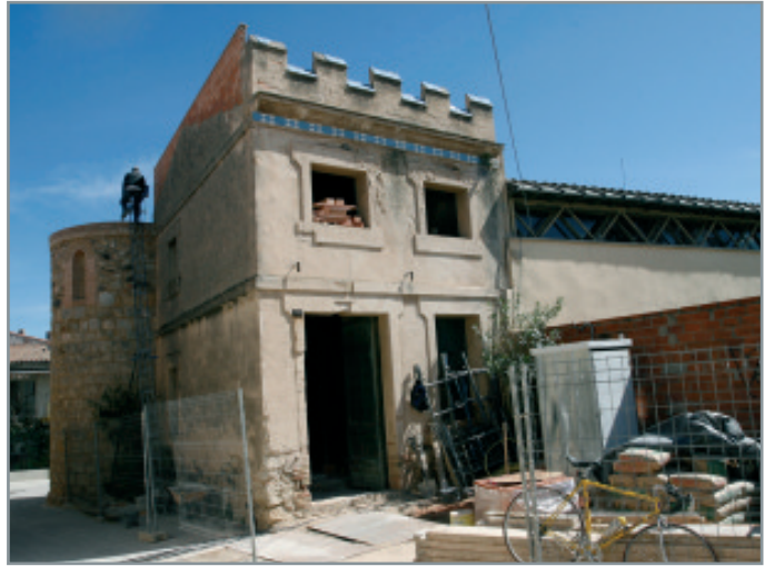
El local de joves, en construcció. Foto: Albert Torrent
