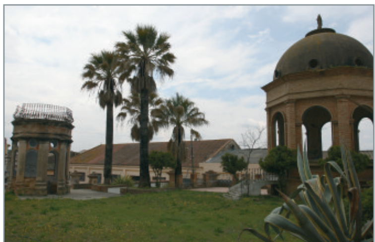
La zona a rehabilitar
