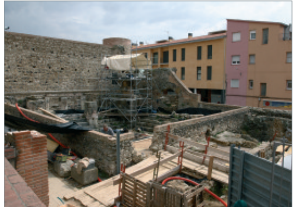
Obres de restauració de les Termes. Foto: Albert Torrent
