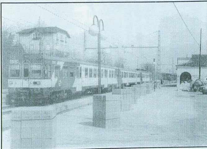
Obres a les andanes de l'Estació
