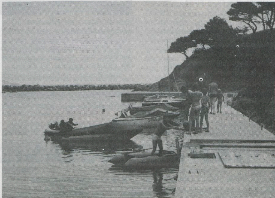
El muelle junto a Punta Prima ha sido ya "estrenado" por las primeras embarcaciones, pese a que se está trabajando en la colocación de todos los servicios, según se puede ver en los boquetes abiertos y por donde pasará el agua y la instalación eléctrica y telefónica (Foto Sureda).
