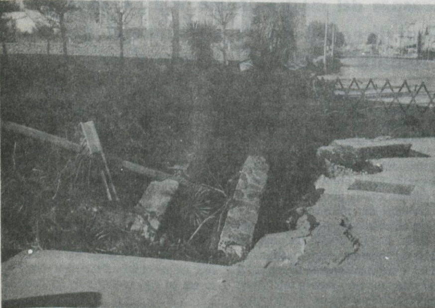
La Trencada. Aquí Obres Públiques hi ha de construir un nou pont, amb un metre més d'alçària per damunt del nivell actual.
