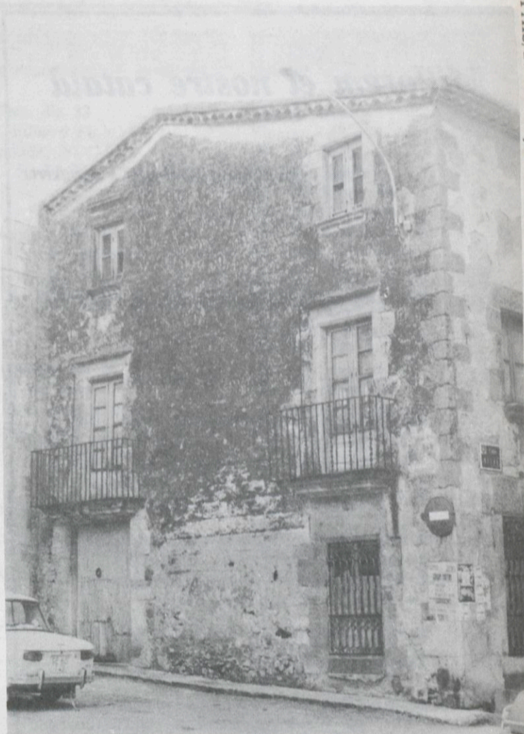
Fachada de "Can Rosés"
