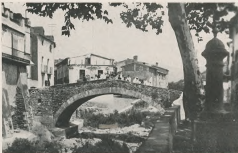
PORRERA. — El pont sobre el riu Ciurana.
