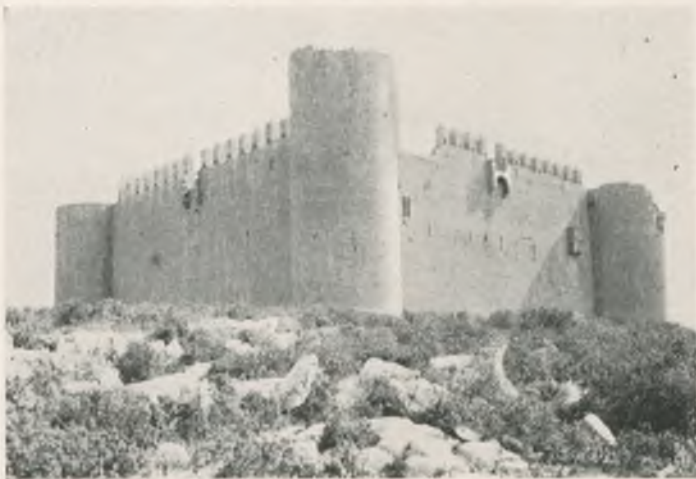
Costat de tramuntana. - Façana de terra endins amb una finestra.
