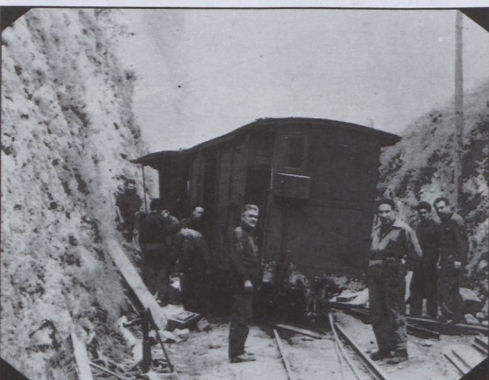
25. Realitzant treballs de recuperació, després d'un descarrilament.
