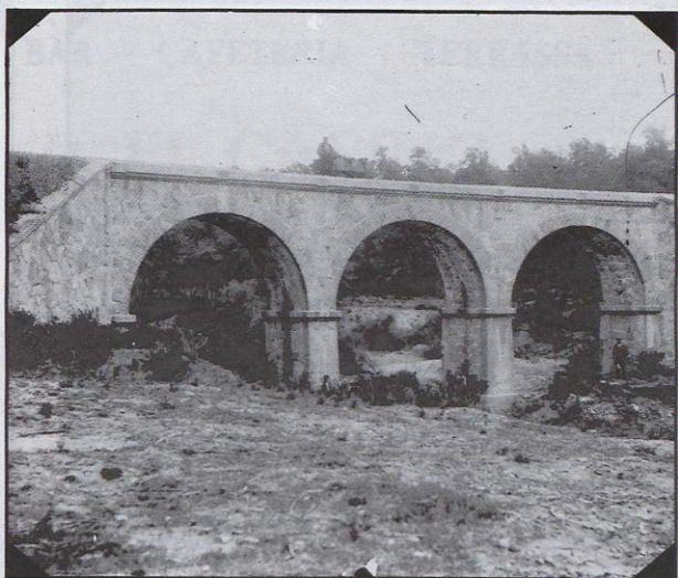
16. Pont de Salenys fet d'obra
