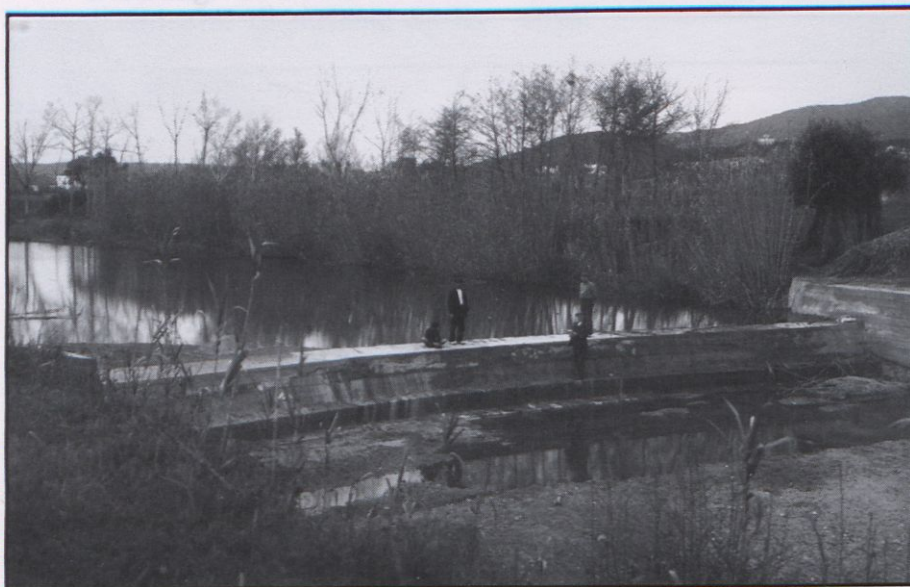
Resclosa de formigó construïda a començaments d'aquest segle, als camps de Santa Maria, molt a prop del camí ral, a Santa Cristina d'Aro.
