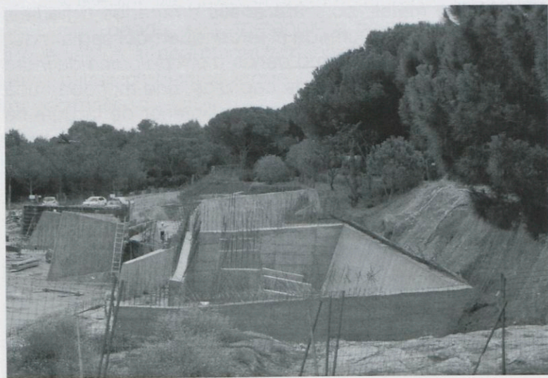
Imatge de les obres de construcció del nou edifici de recepció de visitants.
