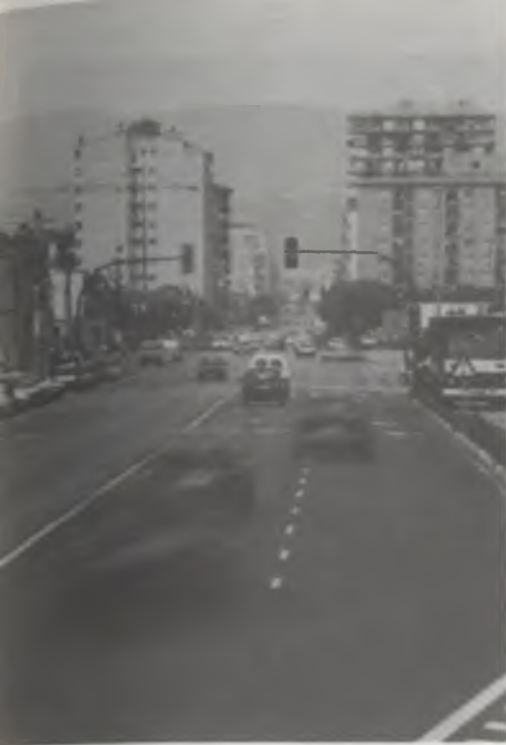
La prolongació del Pg. dels Països Catalans cap a Bescanó, amb l'obertura d'un nou pont sobre l'autopista, ha estat una obra important dins l'urbanisme de Salt.
