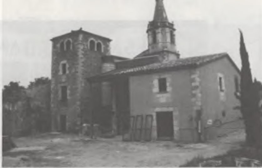
El Mas Llorenç presenta un aspecte renovat després de les obres de millora i restauració que s'hi han fet.
