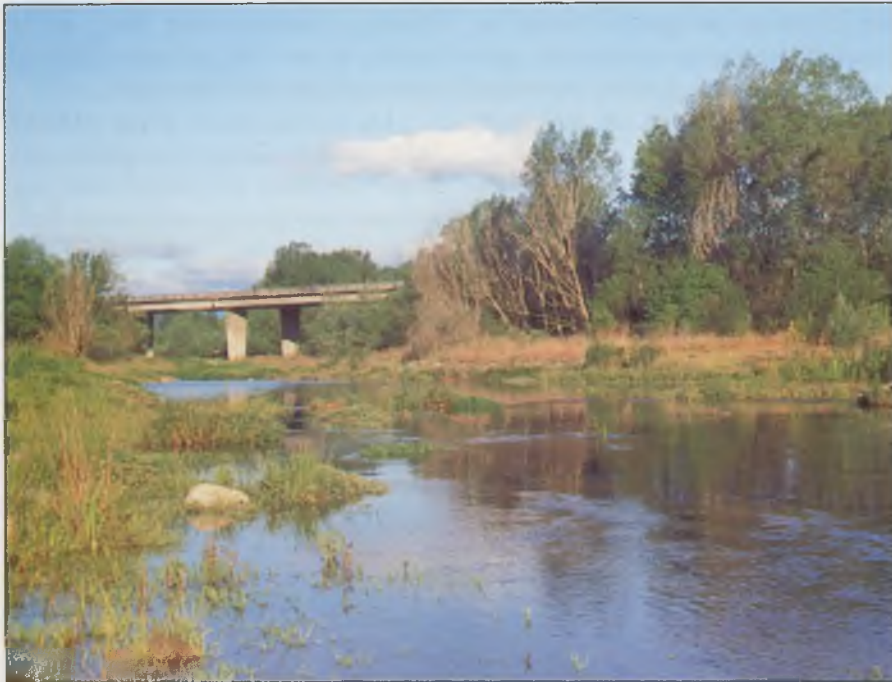
El Ter i el pont de l'autopista
