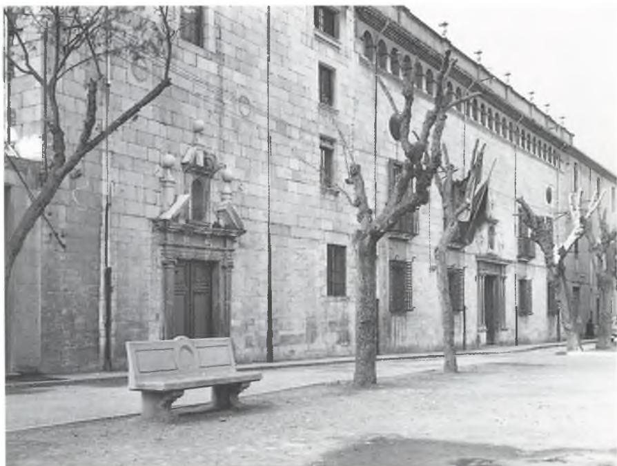
Façana de l'actual Hospital de Santa Caterina.
