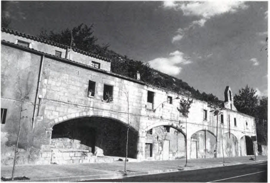
Exterior de l'Hospital de Sant Llàtzer, al carrer de Pedret.
