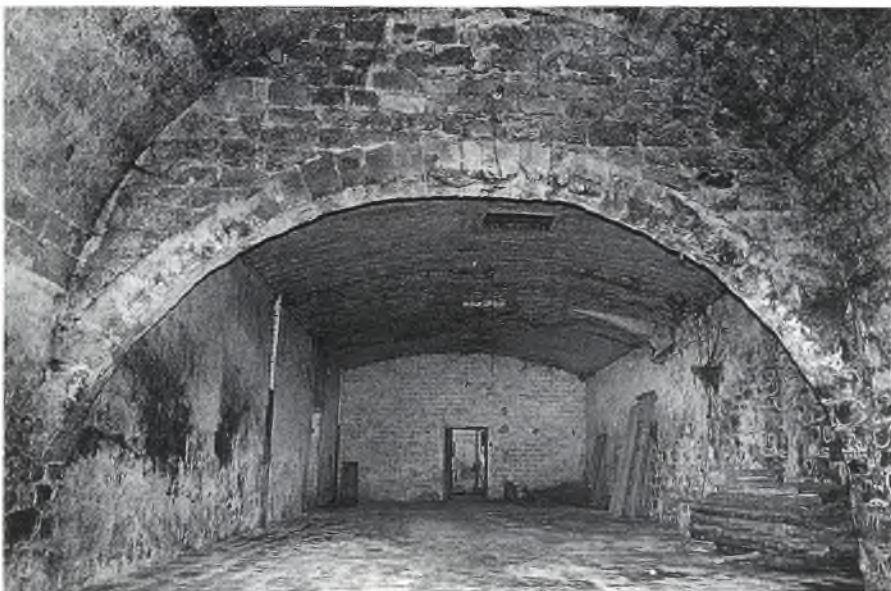
La sala dels homes, lloc on s'han conservat restes del parament romànic original.
