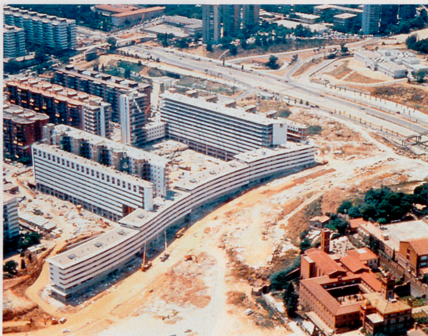
Habitatges de la Vila de Premsa de l'Àrea de la Vall d'Hebron. Juny 1991 (E. Maynés - IMPUSA).
