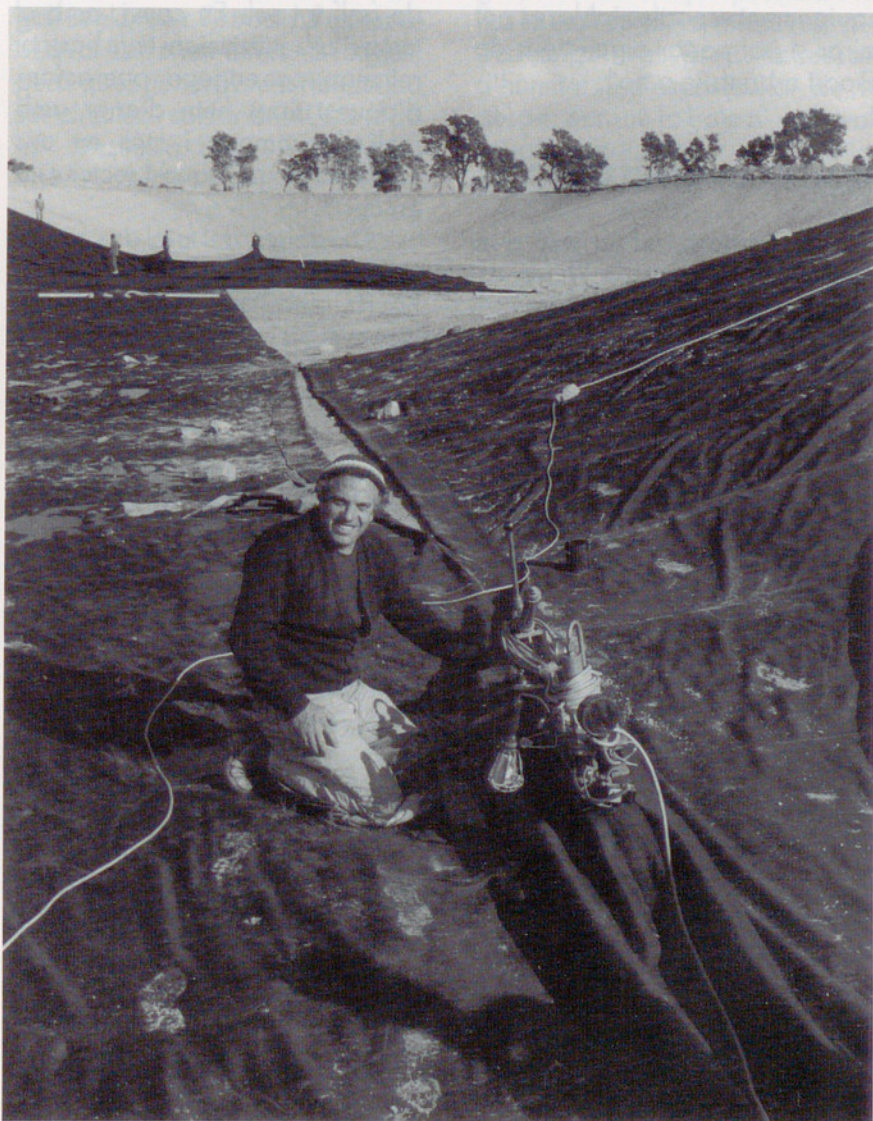
Material impermeabilitzant que es posa al fons dels estanys artificials dels camps de golf.
