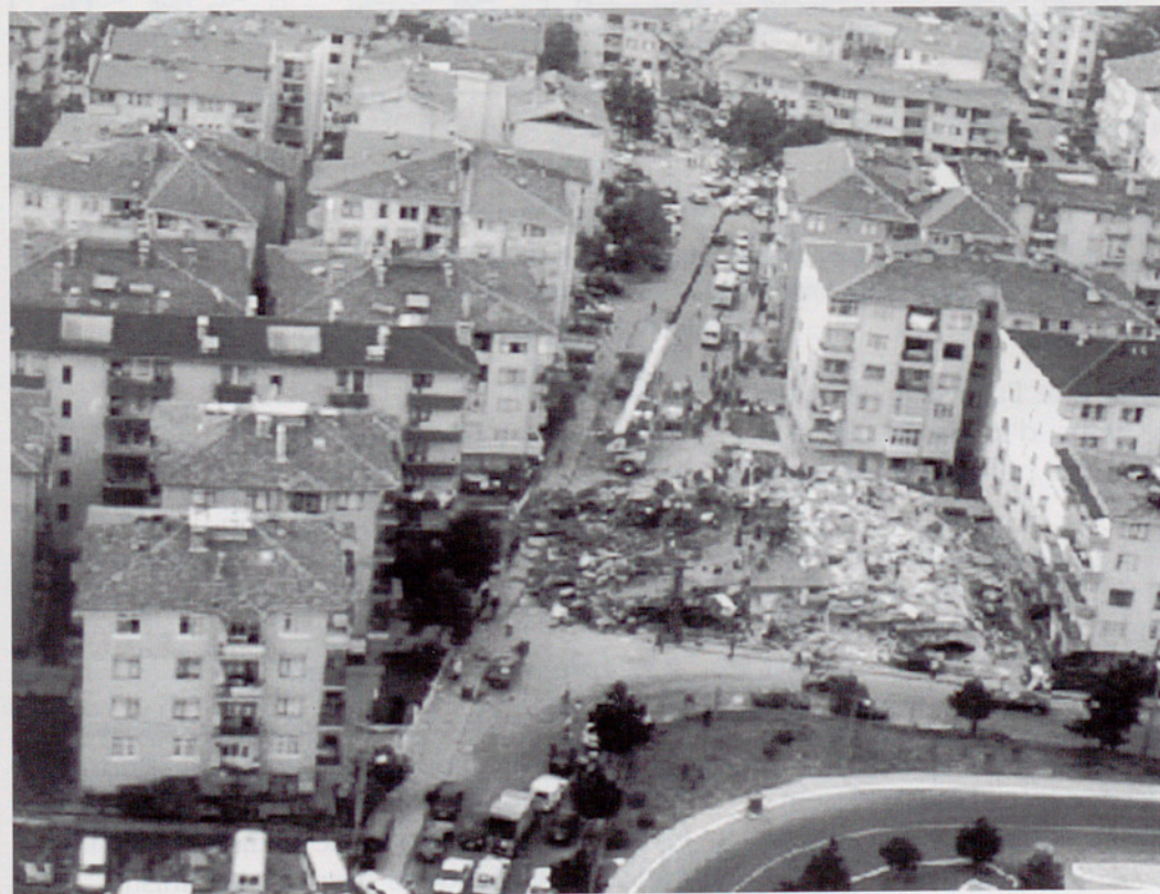
Terratrèmol d'Izmit (Turquia). Edifici totalment col·lapsat, envoltat d'altres que han tingut una resposta adequada.
