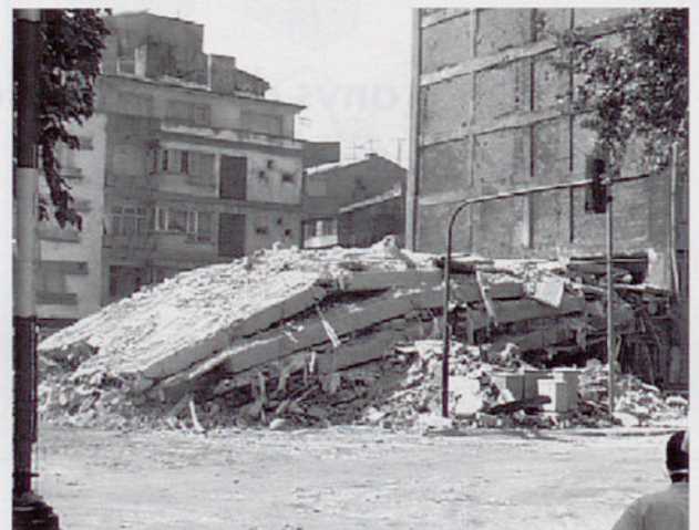
Terratrèmol d'Izmit (Turquia). Amuntegament de sostres per fallada dels elements verticals.
