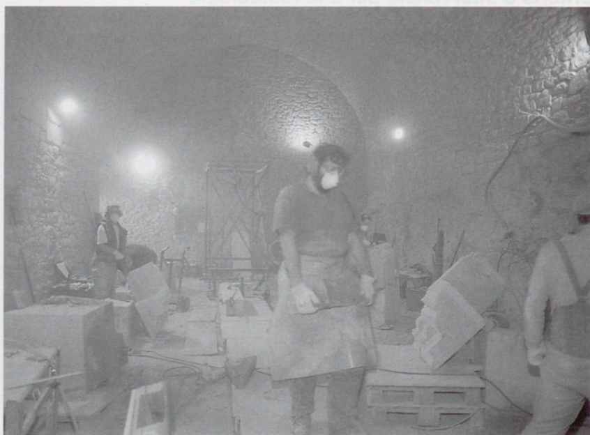
Espai habilitat pels treballs de restauració de la pedra.
