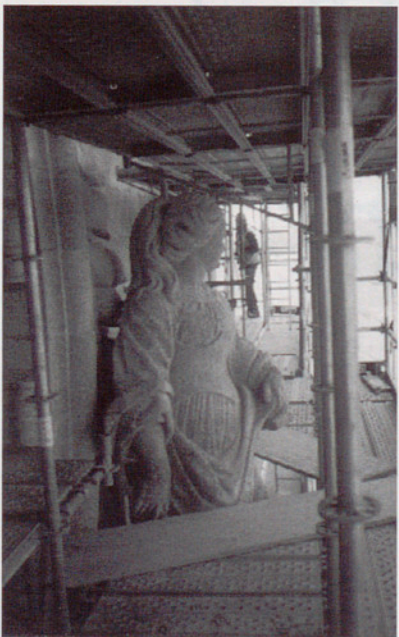
Detalls de la façana en fase de treball.
