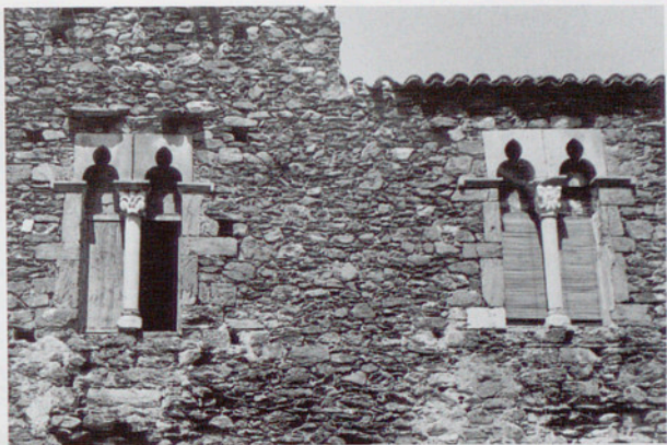
Fa anys, les finestres gòtiques del sector de migdia del monestir tenien col·locats elements (columnes, bases i capitells) romànics que devien procedir de les galeries del claustre bastides al s. XII.
