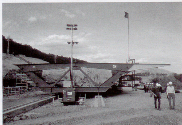
L'estructura d'acer, a punt de ser llançada sobre el Fluvià.
