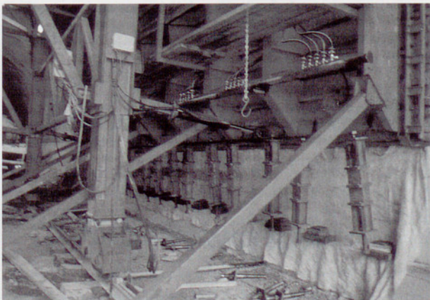
Fotos de l'encofrat dels túnels.
