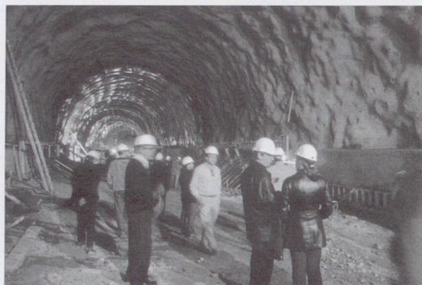
Interior del túnel, en construcció.
