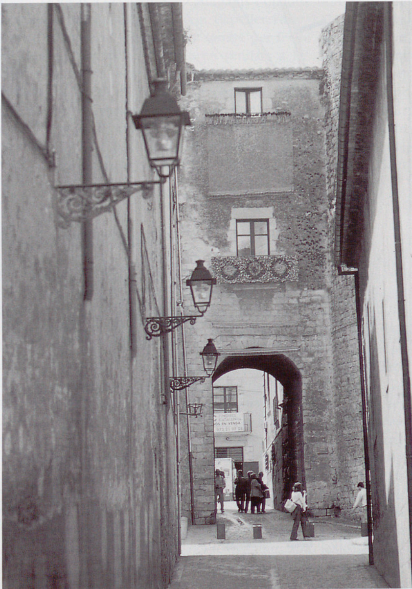
El portal de Sobreportes vist des del carrer Rei Martí.
