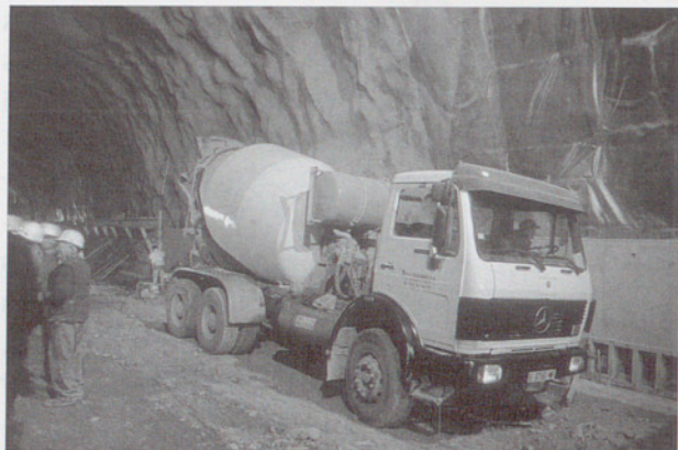
Interior dels túnels en construcció.
