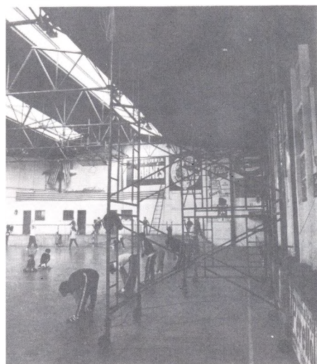
Obres al Pavelló Foto: J. Comalat
