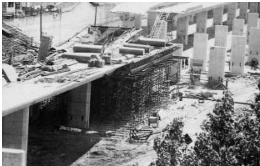
Construcció dels pilars de formigó de l'actual viaducte en el tram de la nova estació del tren, any 1971. (Foto postal: Jufer).
