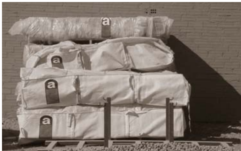
Residus d'amiant preparats per al trasllat a un altre abocador.
