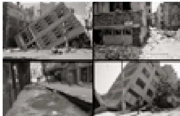
Figura 6. Efectes de la líquüefacció del terreny sobre alguns edificis, observats durant el sisme de Kocaeli de 1999 (Roca et al., 2006).
