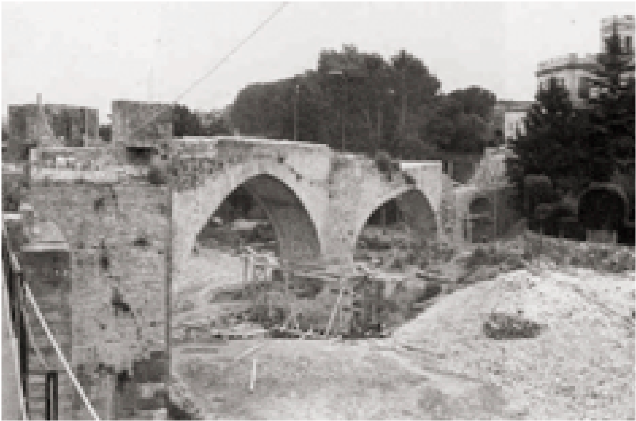
Vista del segon sector del pont, durant les obres de restauració que s'hi feren als anys seixanta, on es pot observar l'estat general del pont i les obres de refonamentació que es dugueren a terme.
