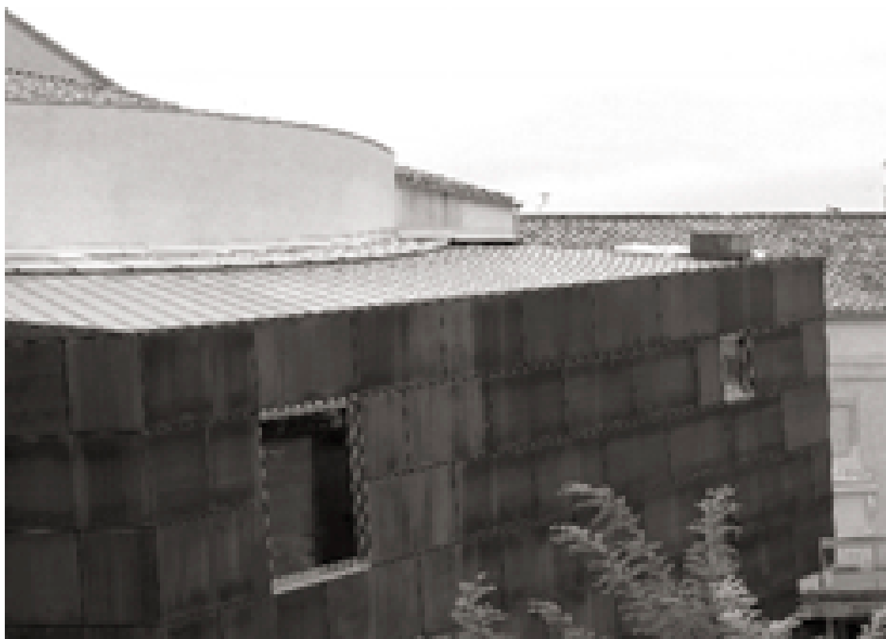
Detall de coberta i façana.
