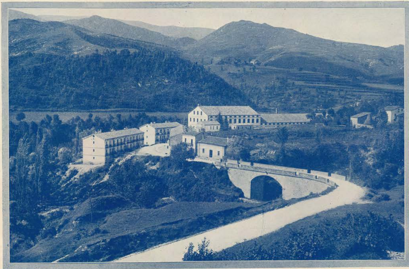
Vista general de la Fábrica de Hilados y Torcidos de José Laudet, S. en C.
