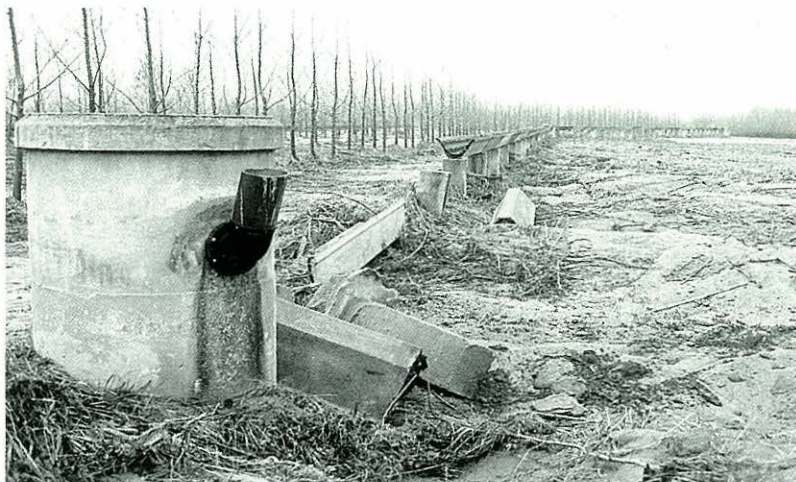
Trencament de canals per l'obertura de comportes del pantà el 1987.
