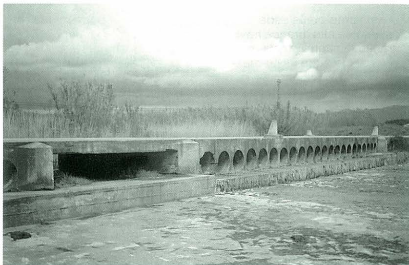
L'any 1903 es va construir el gual sobre el riu Muga, tot sovint inundat i que va prestar servei fins l'any 2000, en què ha estat substituït per un pont.
