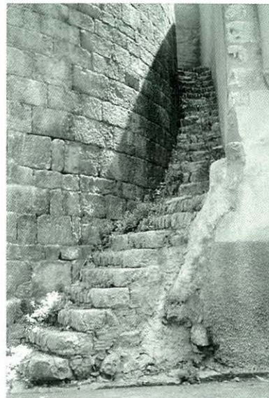
Escala de pujada a la torre, que és de forma cilíndrica i amb carres de pedra treballada.
