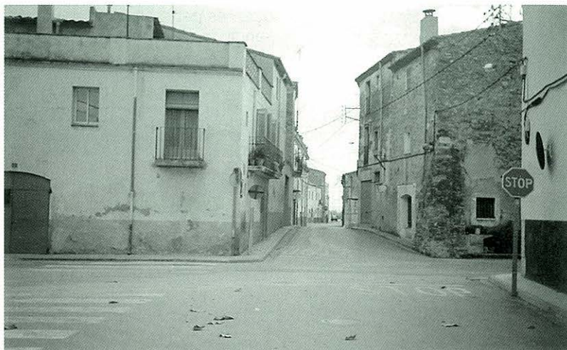
Entrada al poble pel carrer del Canal, abans de l'enderrocament de les cases de la cantonada.
