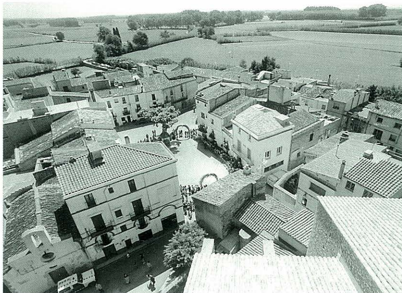
Vista aèria de la zona de la Casa de la Vila.
