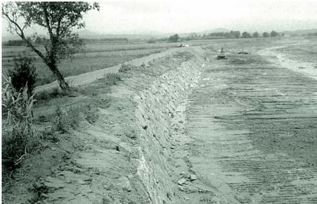
Obres de reconstrucció de mur de contenció després dels aiguats de 1987.
