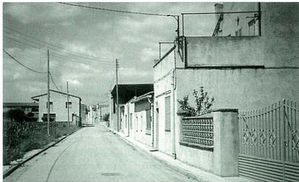
Veïnat de Masies de Dalt, elevat mig metre del nivell de les terres per evitar inundacions.
