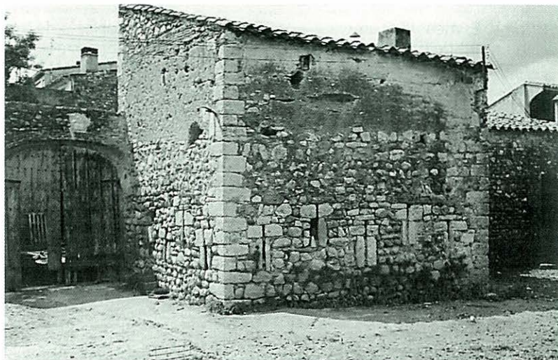
Pany de paret encara existent que formava part de la muralla.
