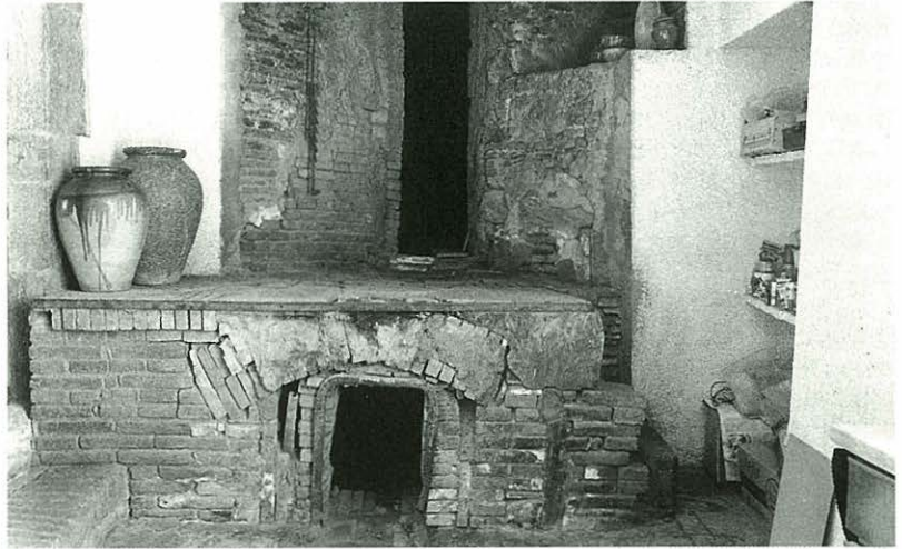
Aspecte parcial d'un forn morú amb la boca de la foganya i la porta de la cambra del forn. (Terrisseria Salamó. La Bisbal.)
