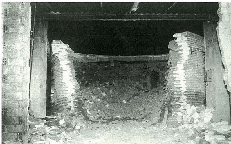
Enderroc d'un forn de flama invertida.
