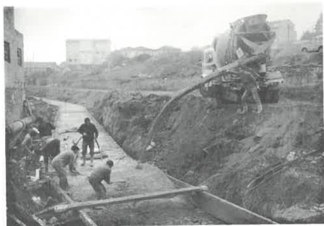
Quant a obres públiques realitzades, té una importància vital la cobertura del Torrent d'en Serras. En la foto es pot veure la construcció de la base per assentar-hi la volta.
