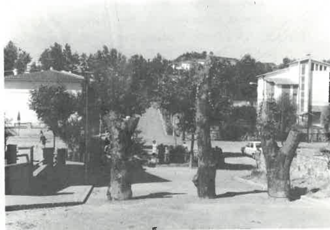
Una visió del modern Passeig de la Font del Ferro amb els arbres recentment col·locats.
