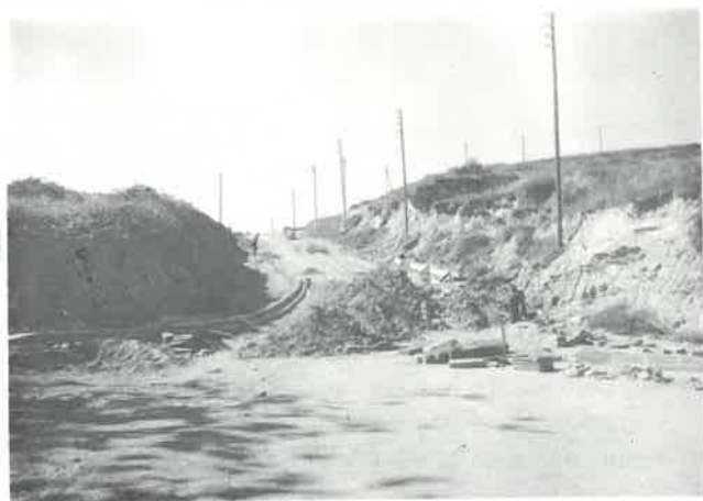
Un pas més en les obres del camí del Cementiri i futura Plaça d'Espanya.
