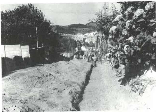
Una de les tasques importants que s'han iniciat és la construcció de clavegueres, paviment i enllumenat del Carrer de Santa Margarida.
