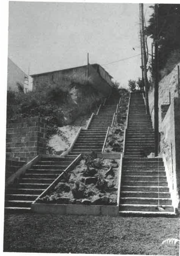
Les noves escales que enllaçan el Passeig Víctor Pradera amb la Plaça Tintoré, tocant a la carretera d'Arbúcies.
