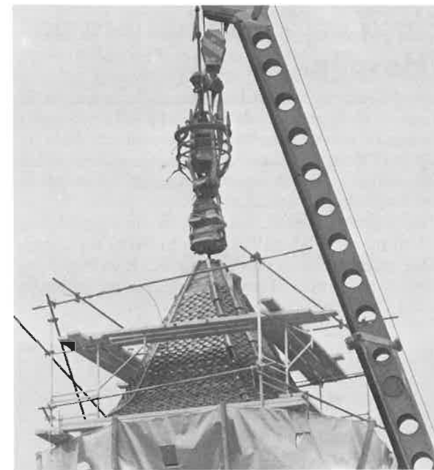
Reparació del Campanar.
