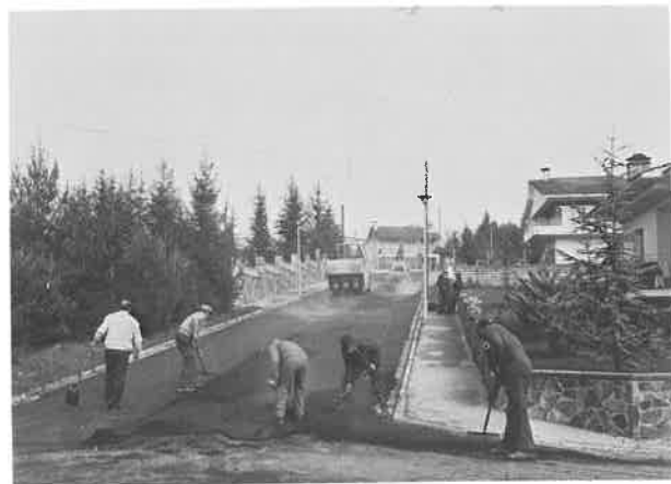
Obres de reasfaltament de diferents carrers de la vila.
