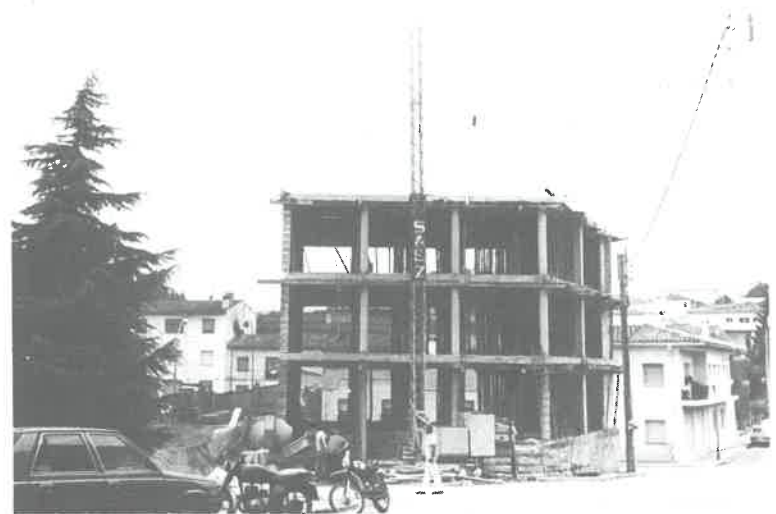
Obres del que ha de ser la Casa de Cultura.
