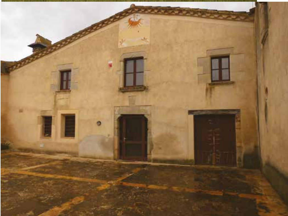
Mas Vilabella: façana est i façana sud
