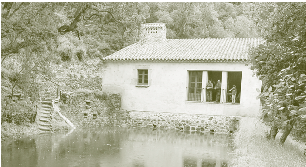
El molí d'en Frigola, a Sant Sadurní de l'Heura, ha estat restaurat per l'Escola Taller les Gavarres del Consell Comarcal del Baix Empordà. Autor: Consorci de les Gavarres
