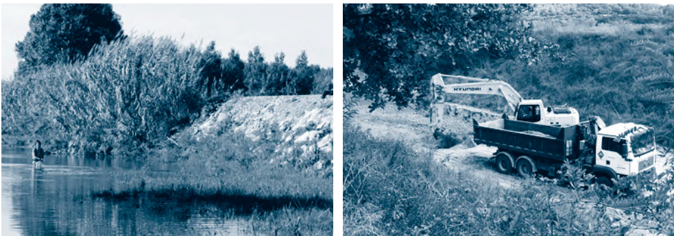
Figura 11. L'endegament de la llera suposa, entre altres conseqüències ecològiques negatives, la degradació severa de l'hàbitat per als peixos
