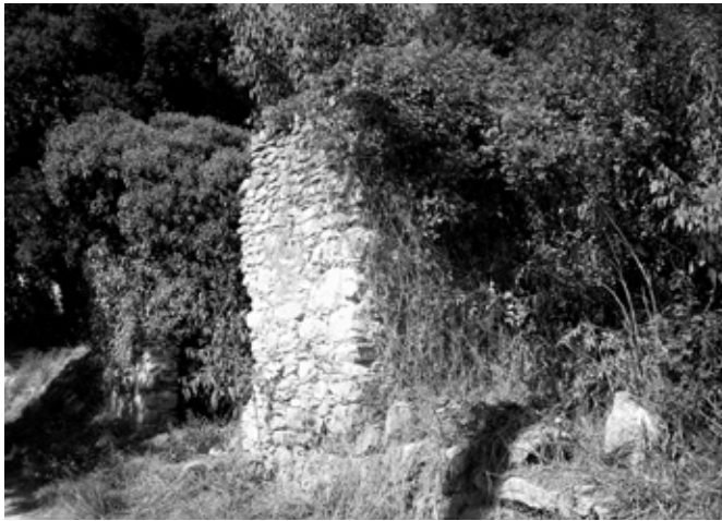
Forn del Ferrer, exemple de forn exempt, força diferent de la majoria que localitzem a les Gavarres, excavats i aprofitant un marge o un desnivell. Autor: Jaume Badias.
