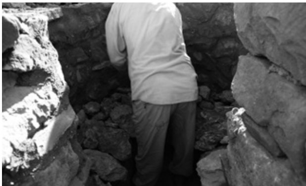
Col·locació dels primers blocs de pedra dins d'un forn de calç l'any 2010 al Mas de Noguera (Caudiel), a la comarca de l'Alt Palància (País Valencià). Font: Arxiu del Museu Valencià d'Etnologia.
