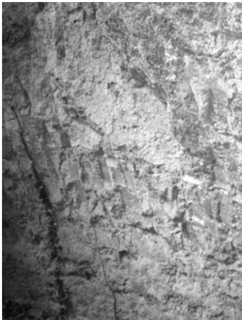
Marques de pic a l'interior del Forn de calç de Cal Xocolater (Corçà). Autor: Jaume Badias.
