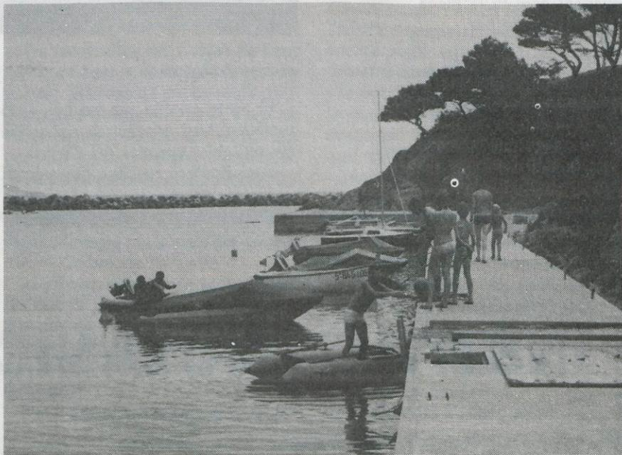
*El muelle junto a Punta Prima ha sido ya "estrenado" por las primeras embarcaciones, pese a que se está trabajando en la colocación de todos los servicios, según se puede ver en los boquetes abiertos y por donde pasará el agua y la instalación eléctrica y telefónica (Foto Sureda).*
