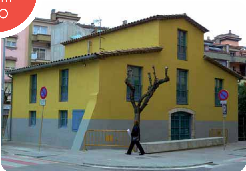
Pere Quero L'edifici després dels últims treballs de reforma
