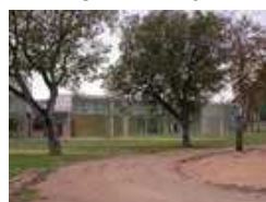
Hospital Sta. Caterina
