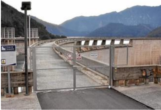
Unes tanques metàl·liques impedeixen l'accés a la presa.
