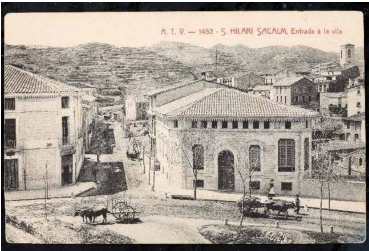
L'edifici de Can Punti a principi del s. XX, destruït durant el bombardeig.
