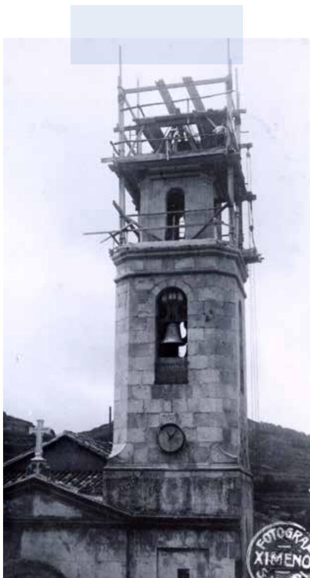
Obres d'ampliació del campanar.
