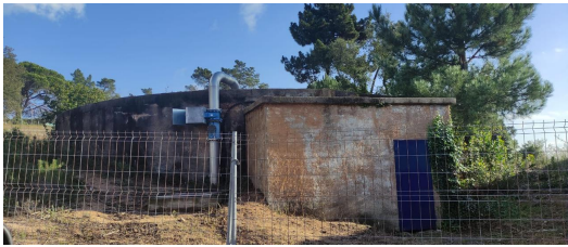
Dipòsit d'aigua urbanització Lloret Residencial.
