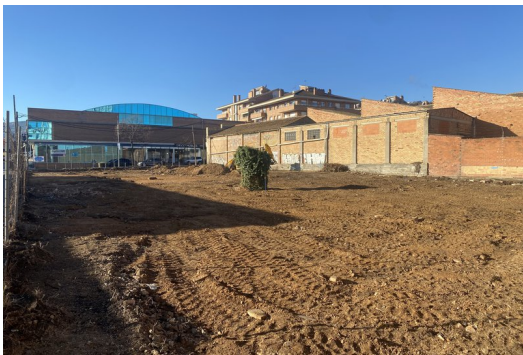
L'espai on s'habilita el nou aparcament del carrer Masdevall. CEDIDA.
