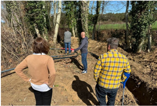
S'inicien les obres per a la canalització d'aigua potable fins a Font Bona.
