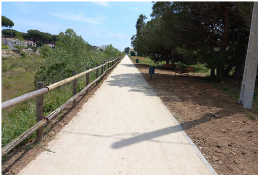
La nova via verda que s'ha habilitat al marge de la riera de Calonge CEDIDA.
