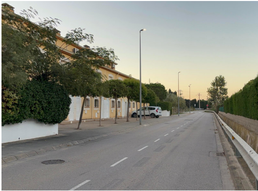
El carrer de Marcel·lí Audivert, on s'instal·larà un altre radar EMD DE L'ESTARTIT.
