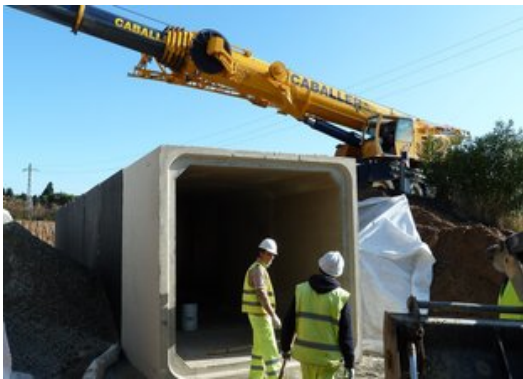
El túnel està fet de mòduls de formigó i passa per sota els ramals de la C-31. Foto: i.r..
