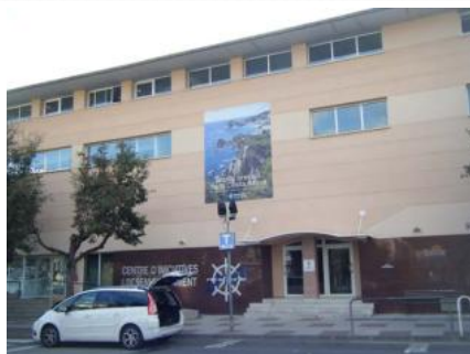
Les noves oficines estaran ubicades a la darrera planta de la Nau. carles colomer
