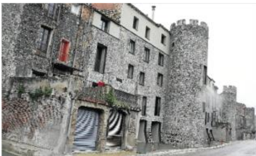
Una part de les muralles d'Hostalric, on les obres ja han estat finalitzades. <br/>
