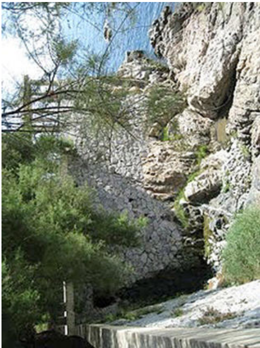
La canalització per on sortien les aigües residuals.<br/>
