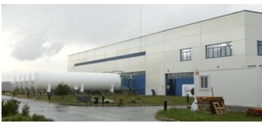
Imatge d'arxiu de la planta dessaladora de la Tordera, ubicada en el municipi de Blanes. Foto: JOAN SABATER.
