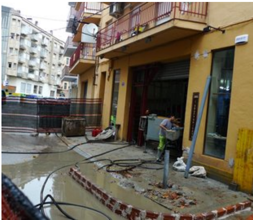
Les obres de l'edifici descalçat, que continuaran unes setmanes més. Foto: NURI FORNS.
