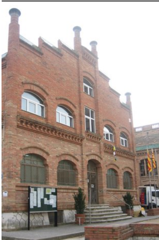
Una imatge de l'edifici de l'Ajuntament de Celrà Foto: J.F.
